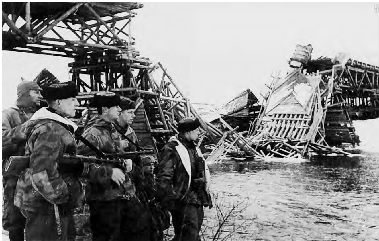
Взорванный железнодорожный мост
