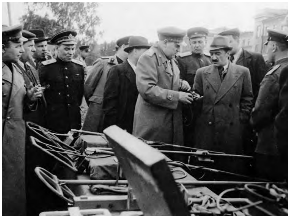
М.П. Воробьев дает пояснения члену ГКО А.И. Микояну по особенностям устройства новых средств инженерной разведки. Полигон Нахабино, апрель 1944 г.
